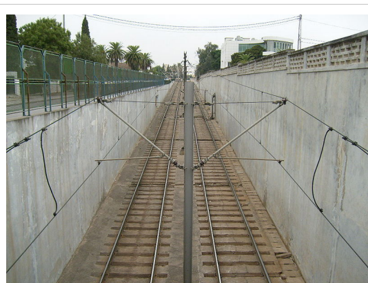
Trémie près de la station Bardo
